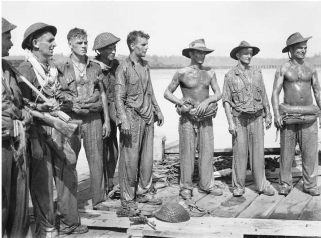
Вымазанные в глине саперы после расчистки проходов в заграждениях (AWM)
