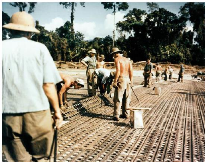
Морские Пчелы укладывают плиты Марстона /Marston plates на новой ВПП для бомбардировщиков. Бугенвиль, декабрь 1943 года
