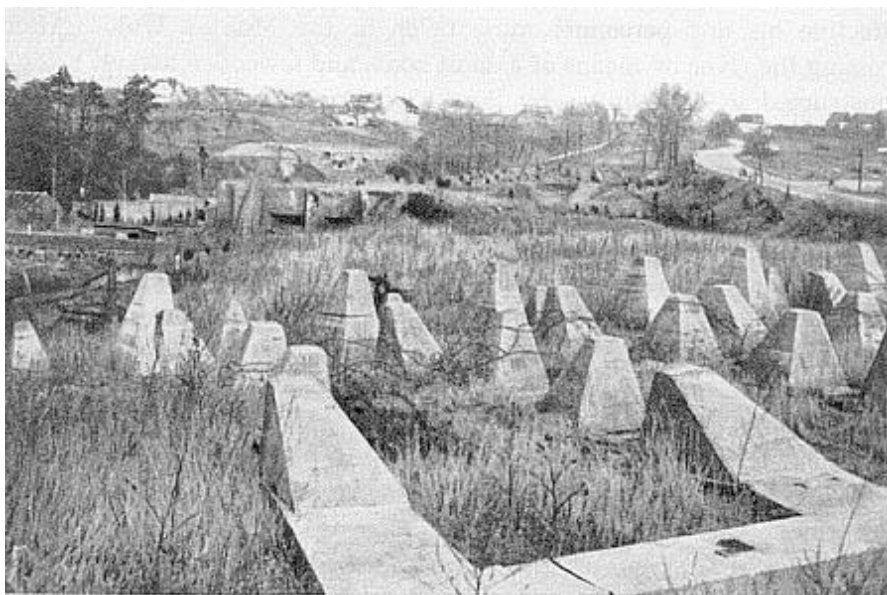
Линия Зигфрида. На переднем плане бетонные надолбы (Зубы Дракона), на дальнем – доты
