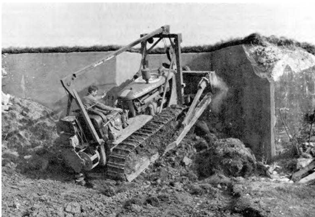
Бульдозер засыпает землей ДОТ в окрестностях Аахена
