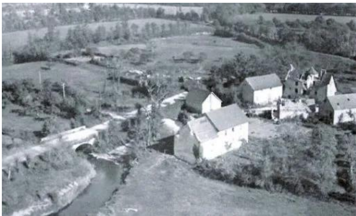
Усадьба Ла-Фьер и мост через Мердере. Вид с запада на восток.
