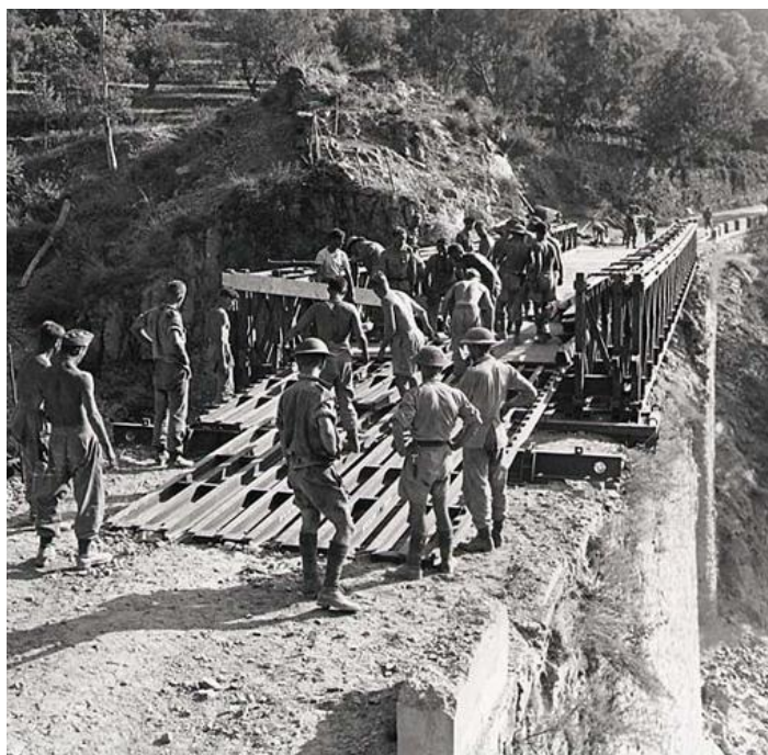
Канадские инженеры устанавливают сборный мост Bailey через глубокий овраг. 4 сентября 1943 года
